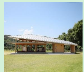
『臼杵市総合公園子ども広場こどもトイレ』 株式会社翔設計室一級建築士事務所 【大分県】
