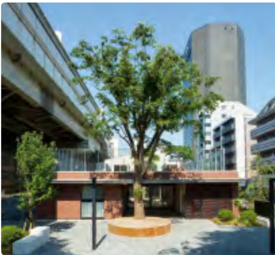
シンボルのケヤキ。街とつながり、街と交わる保育園を目指した。
